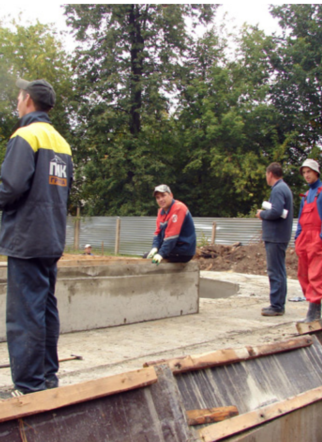
Закладка фундамента новой церкви
